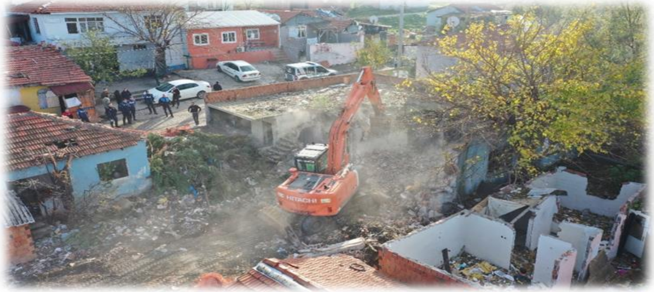
Bağlarbaşı Mahallesi Kentsel Dönüşüm Alanında Yapılan Bir Yıkıma Ait Fotoğraf
